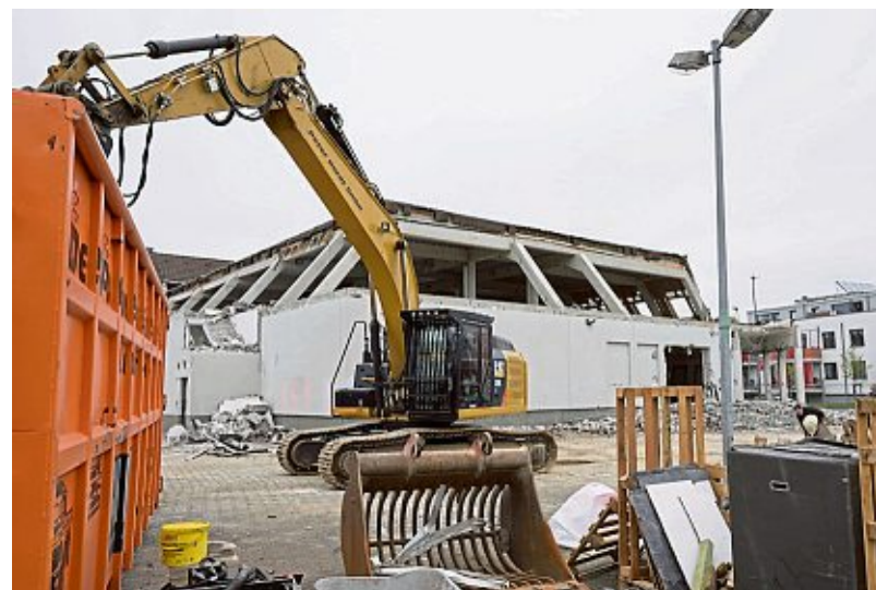
Bagger brechen gerade den Gebäudeteil des Netto-Marktes ab.
