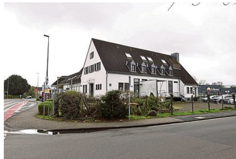
Die Milchsammelstelle vor dem Abbruch.
