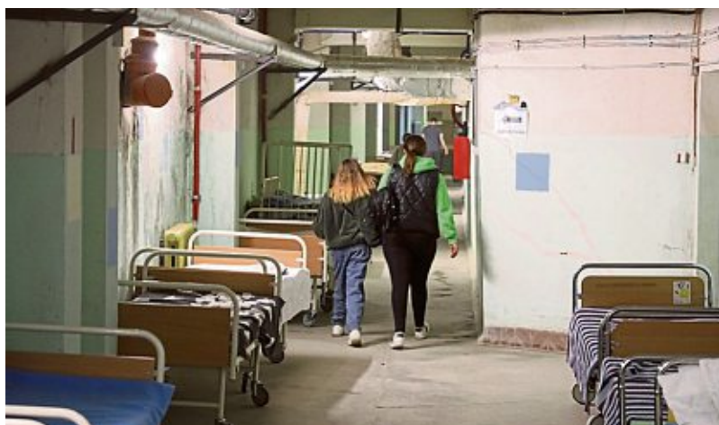
Notdürftig als Bunker hergerichtet sind die Kellerflure der Kinderklinik in Lviv. Regelmäßig gibt's auch im Westen der Ukraine Luftalarm und Einschläge.
